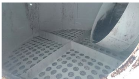
空汙設備塔內清洗
