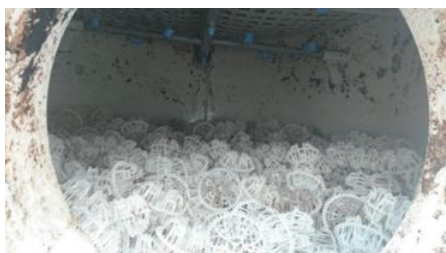
空汙設備拉西環更換
