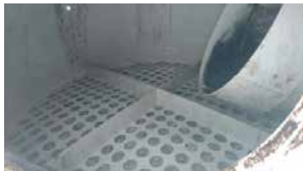
空污設備塔內清洗
