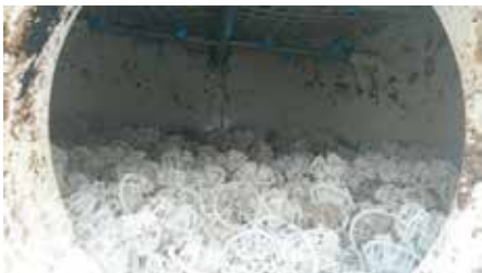
空污設備拉西環更換
