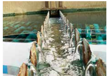
沉澱池出流水
