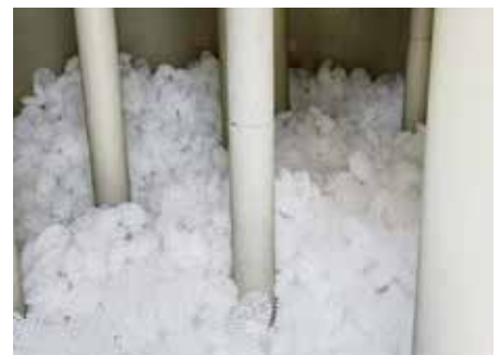
洗滌塔濾材清洗後回填
