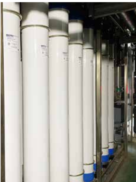
回收水系統UF膜單元
